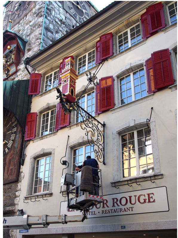
Abb.2: SZ, während der Montage vom 16. August 2019.
